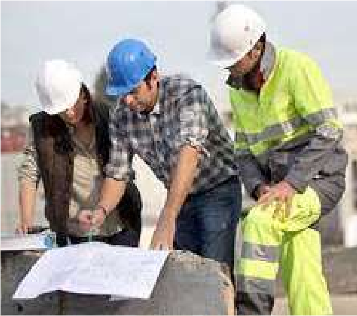
Fig. 1.51. Los encargados de la obra toman acuerdo para realizar los generadores.
