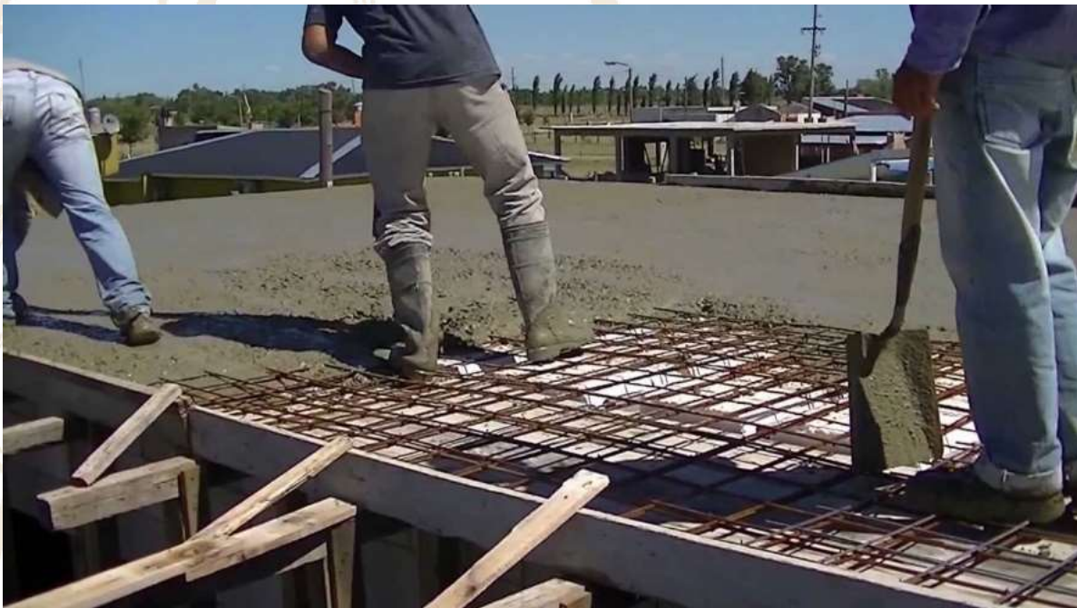
Fig. 1.57. En el ejemplo se el vaciado de concreto en losa.
