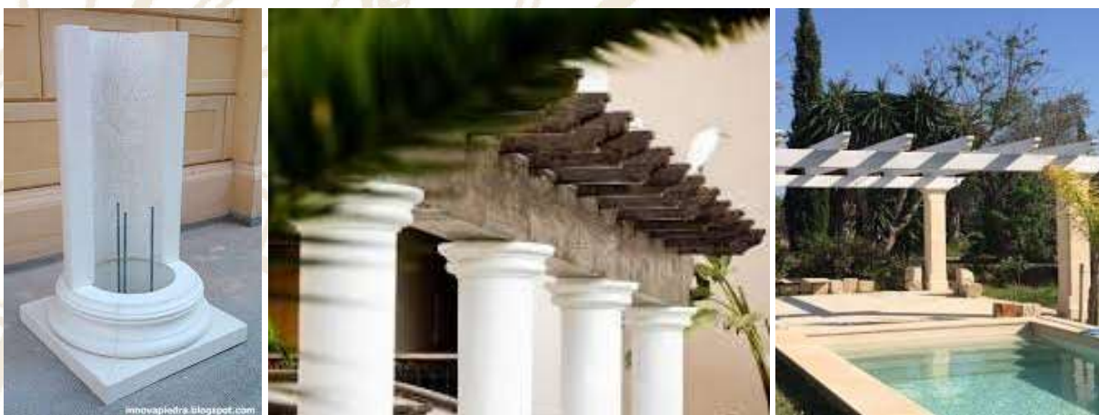
Fig. 1.15, 1.16 y 1.17 Elementos Lineales: Columnas, vigas.
