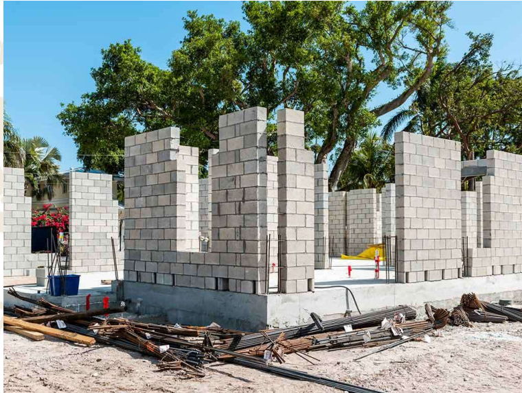
Fig. 1.55. Los metros cuadrados de muro se calculan sin incluir los castillos, columnas o traves.
