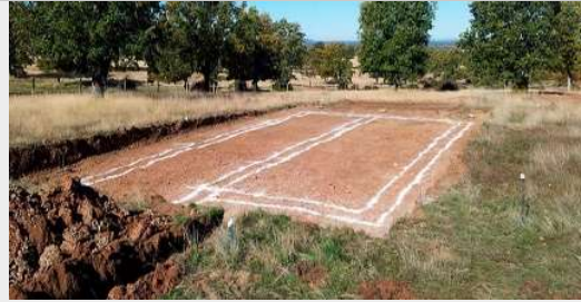
Fig. 1.45. ARREVOL, & Romero Alonso, R. J. (2018, verano). La cimentación marcada sobre el terreno para su próxima ejecución. [Foto cimentación].
