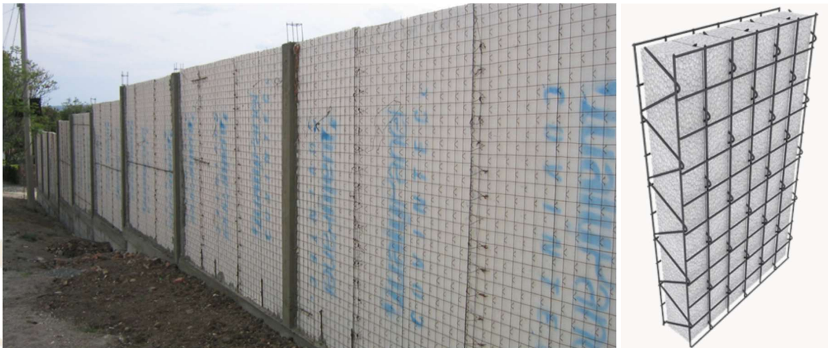
Fig. 1.13 y 1.14 Paneles: Placa de covintec. Construye fácil y rápido, para muros divisorios.
