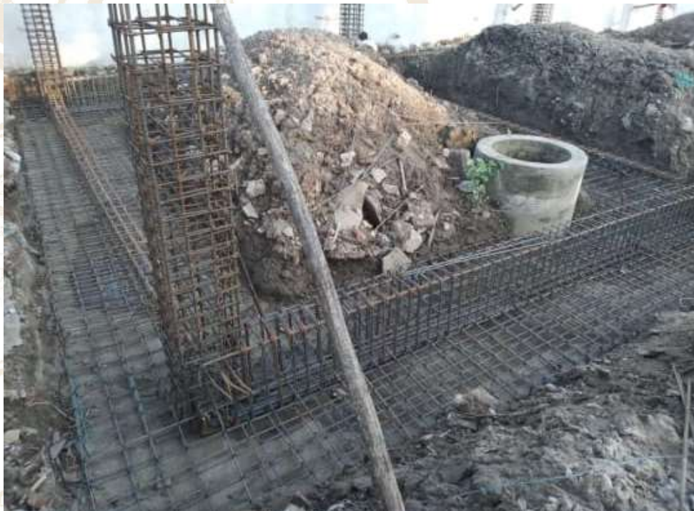
Fig. 1.6. Cimentación, uso de varillas según la necesidad de construcción
