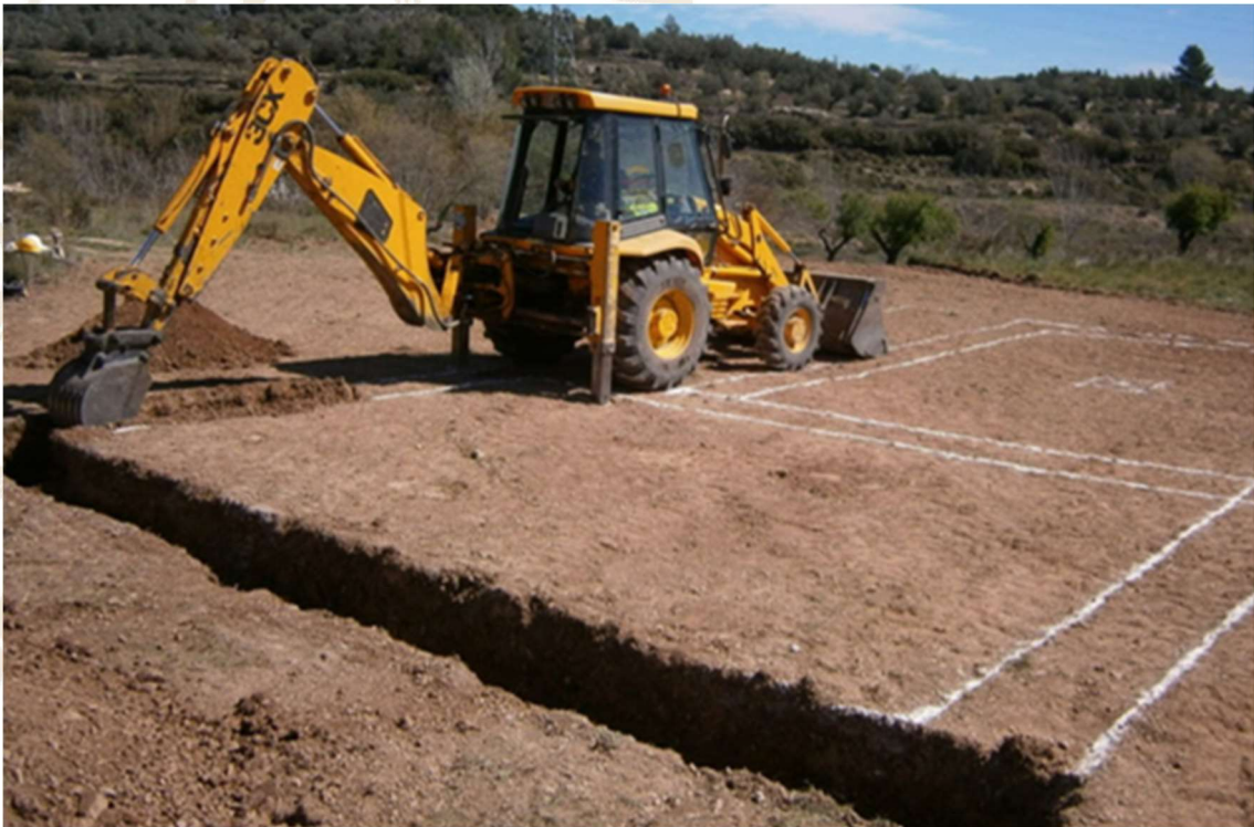
Fig. 1.53. La profundidad de la excavación dependerá del tipo de cimentación propuesta.
