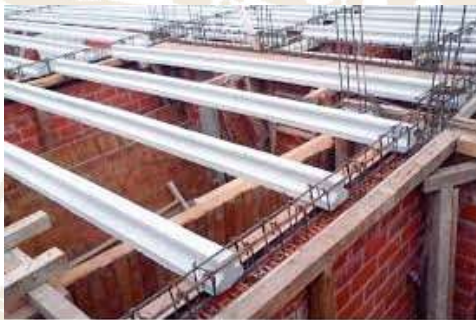
Fig. 1.28, 1.29, 1.30 y 1.31 Material prefabricado. Bovedilla prefabricada. Vigueta y Bovedilla.
