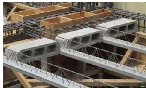
Fig. 1.24, 1.25, 1.26 y 1.27 Material prefabricado. Vigueta pretensada. Vigueta y Bovedilla.
