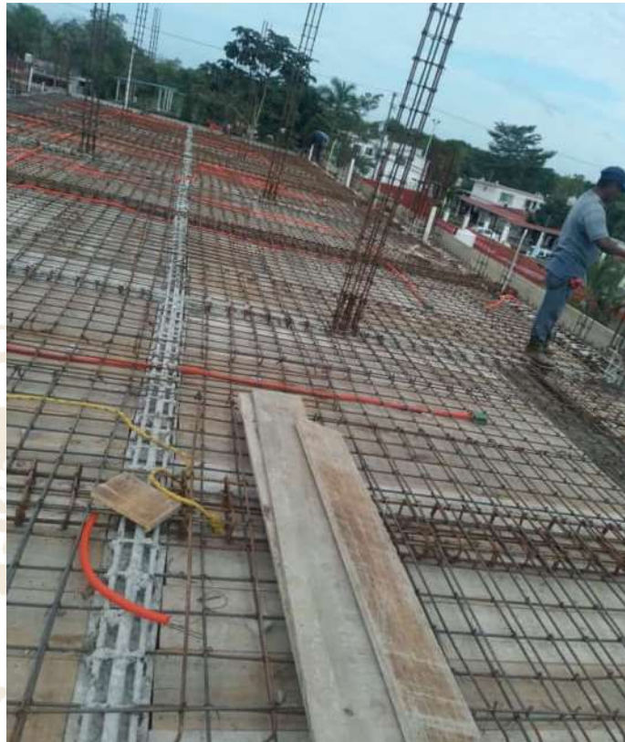
Fig. 1.5. Construcción usando varillas de diferentes medidas.
